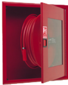
Figur 3-2 Eksempel på godt synlig brannslangeskap med gjennomsiktig dør.
